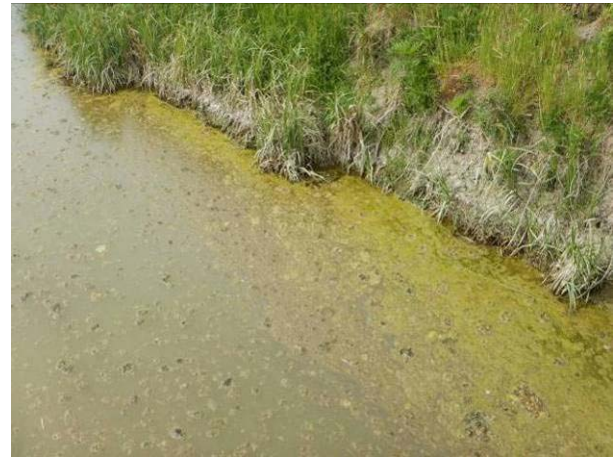
Figura 55 – CA-4: Eutrofizzazione del canale.
