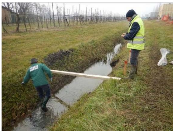
Figura 5 – CO-1: fissaggio del SA al palo in legno trasversale al canale.
