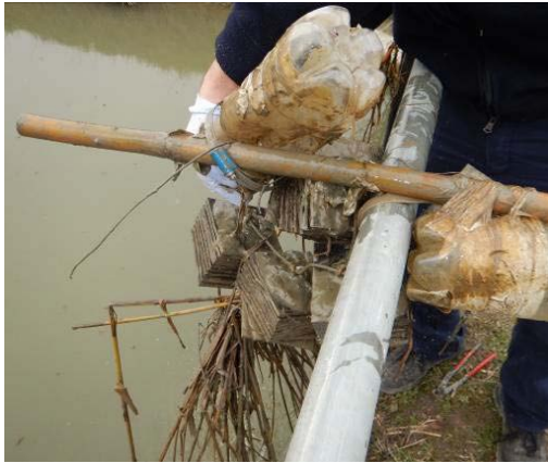
Figura 52 – CA-4: pulizia dei SA dalla vegetazione.
