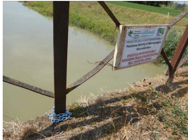
Figura 46 – CABM-3: catena in acciaio che fissa i substrati al ponte.
