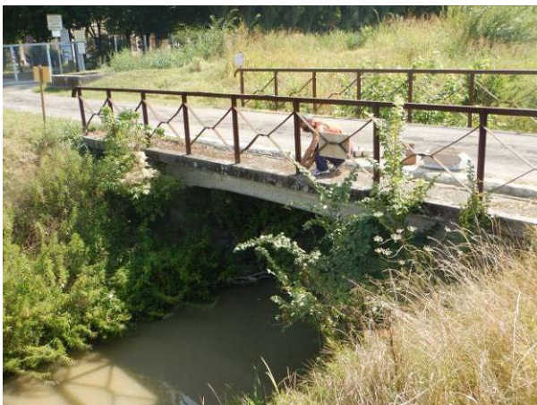
Figura 30 - DFNC-2: ancoraggio dei substrati al ponte.
